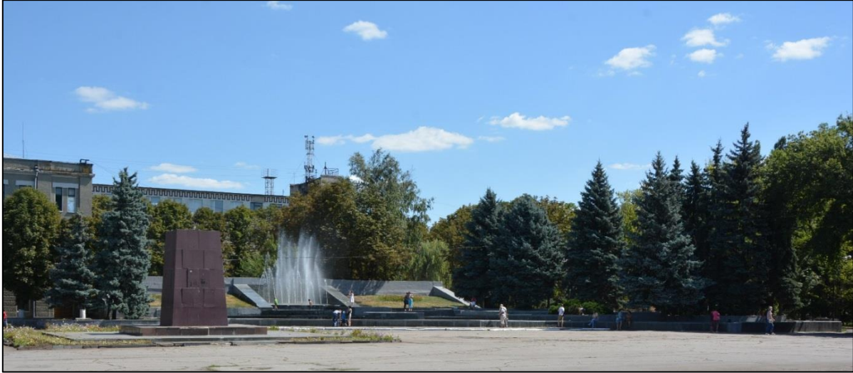
Рис. 2. Площа Соборна до реконструкції [16]
