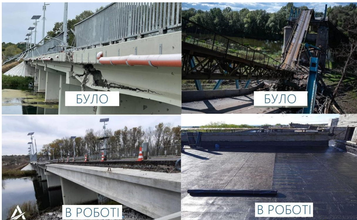
Рис.4. Відновлення зруйнованої транспортної інфраструктури (мостів) у Харківській області [5, 8]
