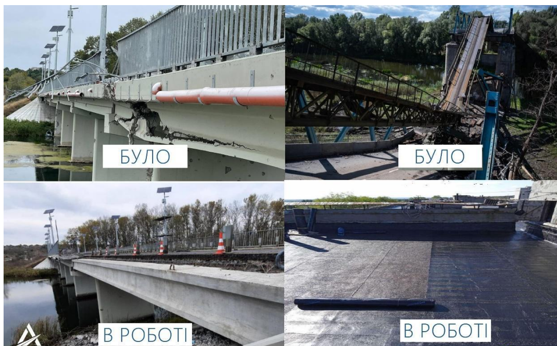
Рис.4. Відновлення зруйнованої транспортної інфраструктури (мостів) у Харківській області [5, 8]
